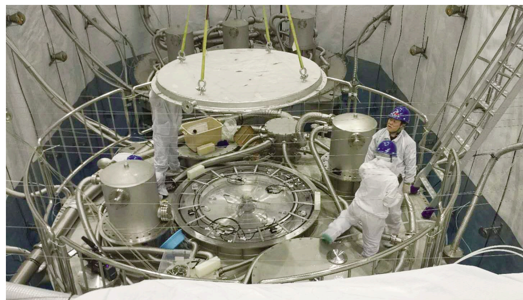
2017年安装中的液闪更换装置
